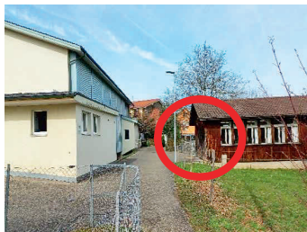
Holz pavillon neben Altem Schulhaus/MZH
